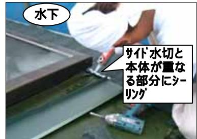
サイド水切りと水上側水切りの重なる部分にシーリングを行い、サイド水切りの上に水上側水切りを被せ、立上り面は取付ビス25mm、水切り水平面は吊子で固定してください。
