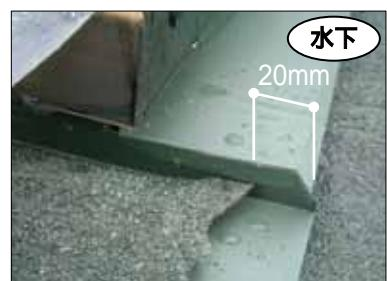
本体と水下側水切りが重なる部分にシーリングとシールテープを施工してください。加工した水下側水切りをトップライト立上り面に取付ビス25mmで取付けてください。
